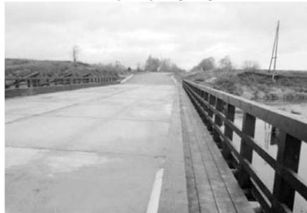
Новый мост протяженностью 46 метров расположен на участке дороги к поселку Бор Парфеньевского района. Деревянный автомобильный мост построен взамен старого аварийного. Для защиты от ледохода на новом мостовом переходе установлены специальные железные ледорезы.
